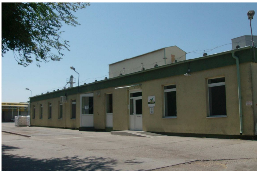
Lajtamag üzem épülete
